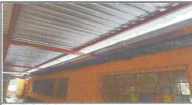
Foto 6: Finalización de proyecto.
