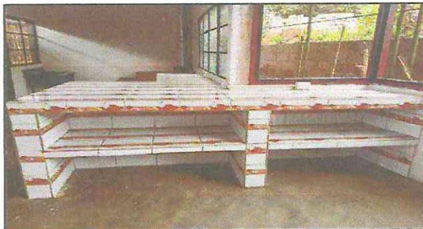
Foto 6: Gabinete de cemento terminado.
