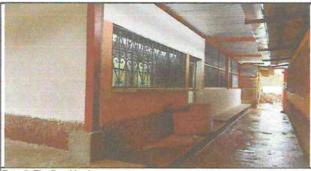
Foto 5: Finalización de proyecto
