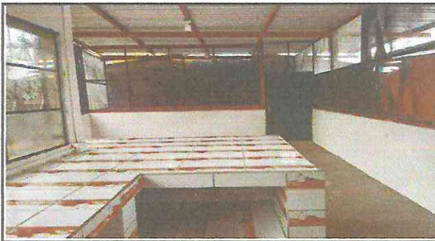
Foto 4: Finalización de proyecto.
