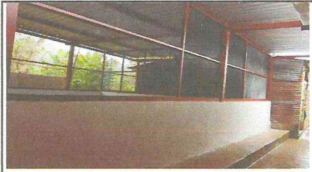
Foto 2: Pared de cocina de lámina con 5 hiladas de block y celosía de metal con lámina mosquitera terminada.
