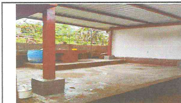
Foto 3: Finalización de infraestructura de metal y lámina troquelada aluzic calibre 26.
