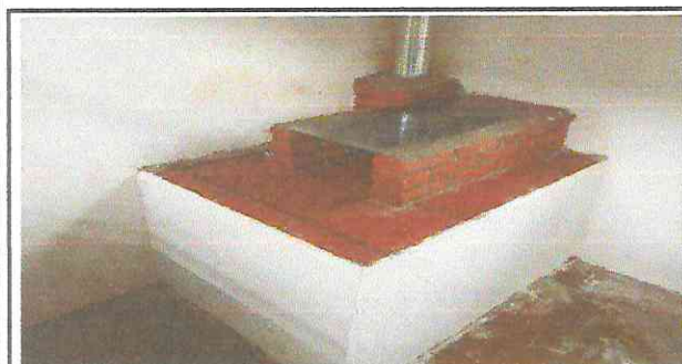
Foto 5: Polletón terminado con su chimenea y plancha de metal.
