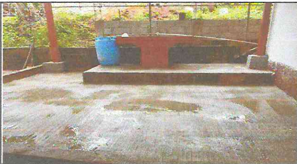
Foto 3: Patio de tierra por torta de cemento terminado
